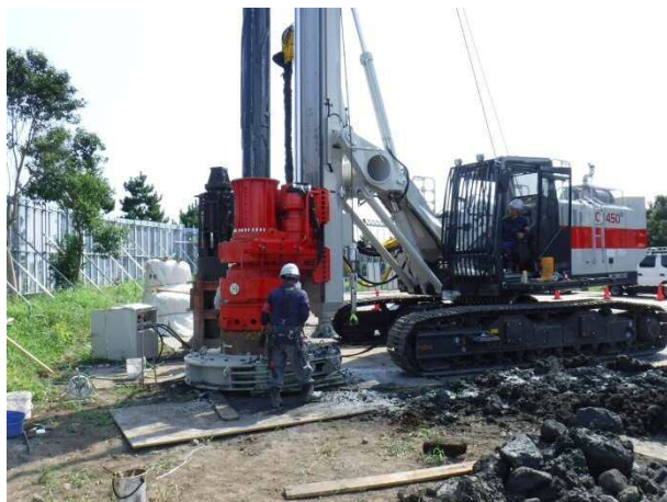
地中障害物撤去 平成29年8月
