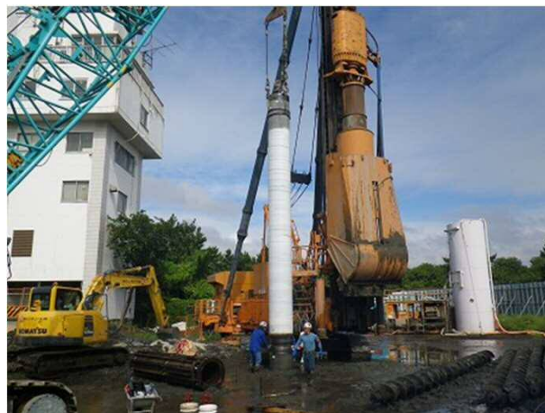
基礎杭打設 平成29年9月
