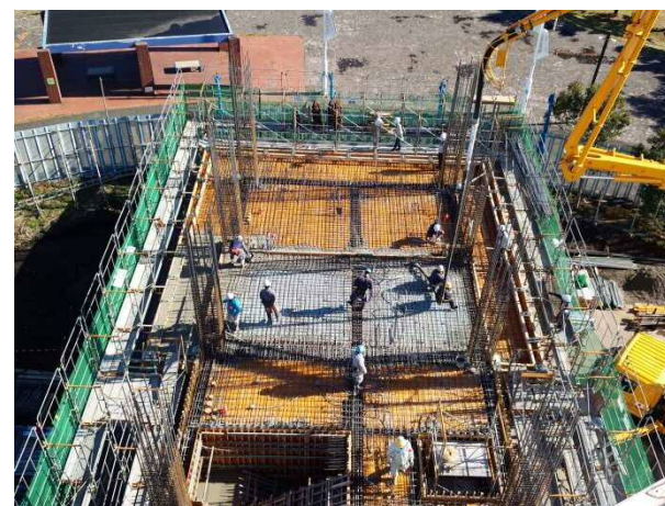
躯体工（コンクリート打設） 平成29年12月
