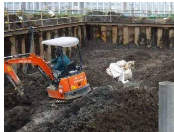
土工（掘削） 平成29年10月
