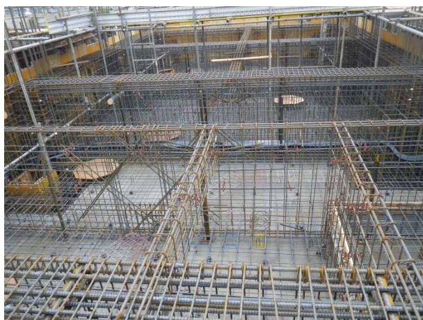
躯体工（基礎配筋） 平成29年11月
