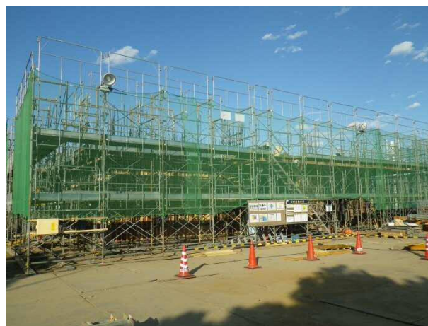
仮設工（足場組立） 平成29年12月
