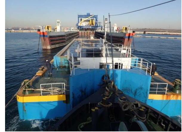
土砂投入（新海面処分場）
