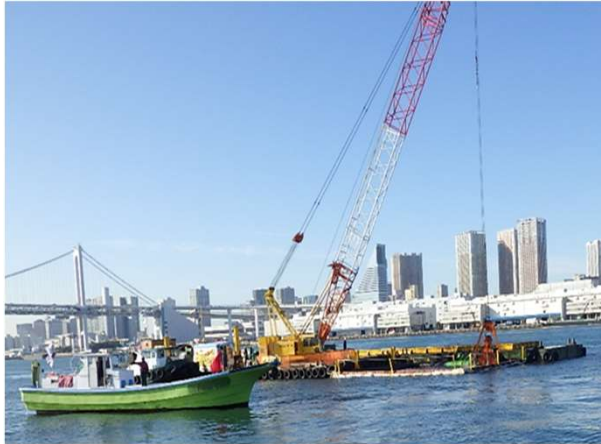
しゅんせつ工（土砂・沈木の除去）
