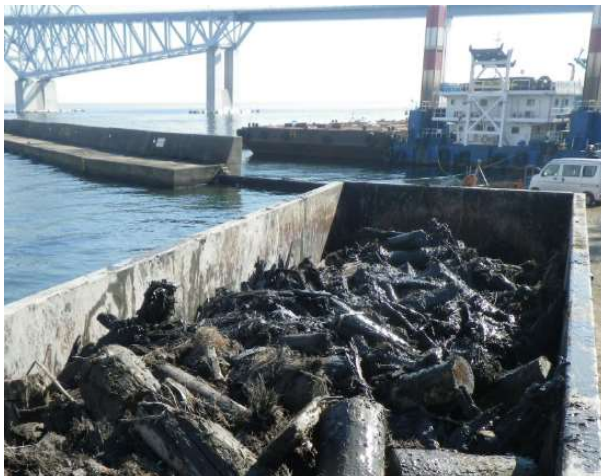
沈木撤去状況
