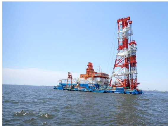
護岸工事（地盤改良工） 平成29年6月
