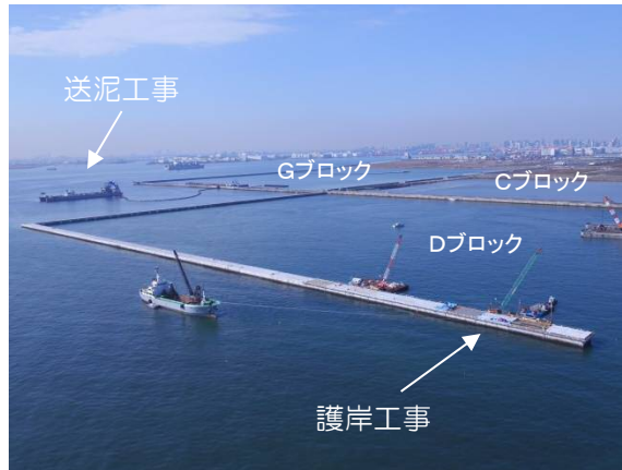
新海面処分場整備状況 平成28年11月
