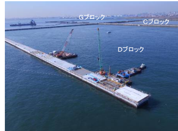
護岸工事（ケーソン上部工） 平成28年11月
