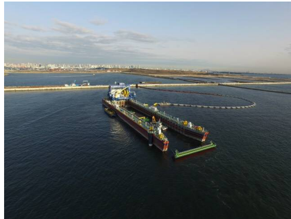
送泥工事（送泥船） 平成29年9月
