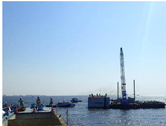
護岸工事（ケーソン据付） 平成28年5月
