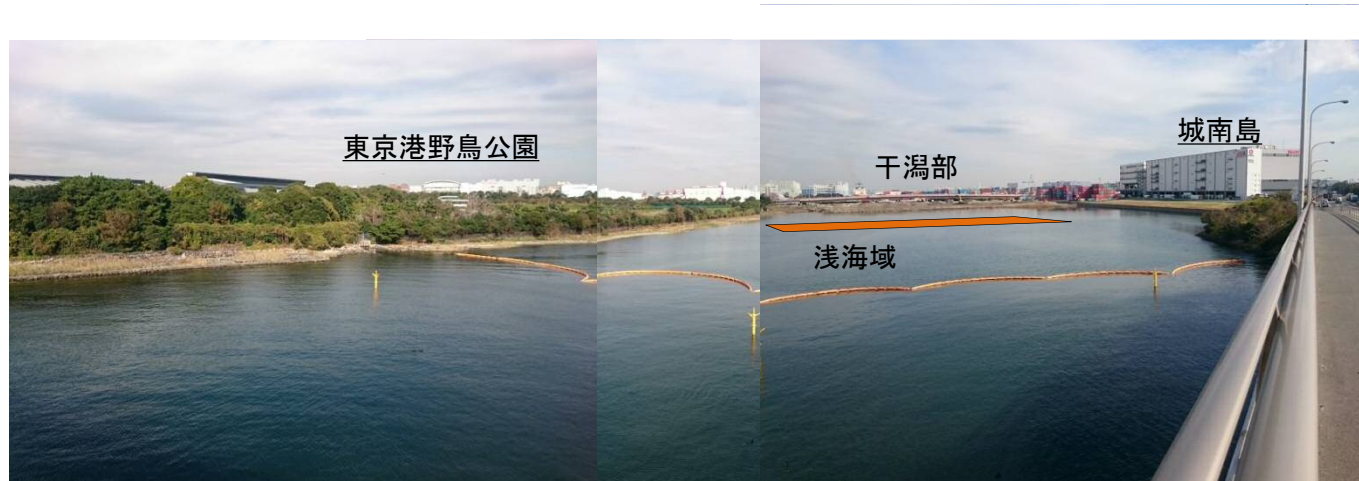
全景 平成29年11月
