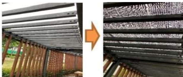
< 遮光ネットの設置 >
