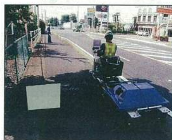
探査機による埋設管の確認作業
