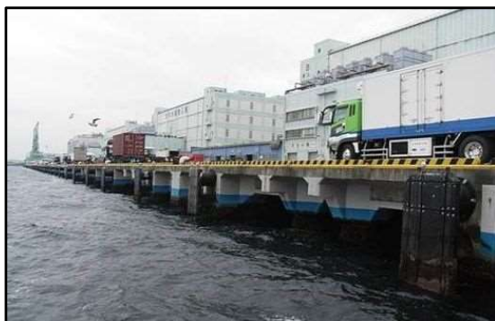
係留施設（栈橋）
