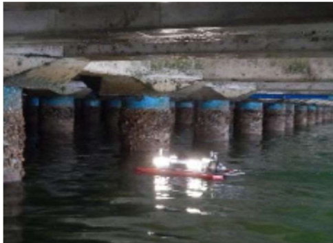
1. ROV を用いた栈橋下面調査
