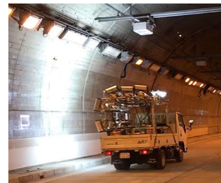
4. 走行型画像計測によるトンネルのひび割れ点検
