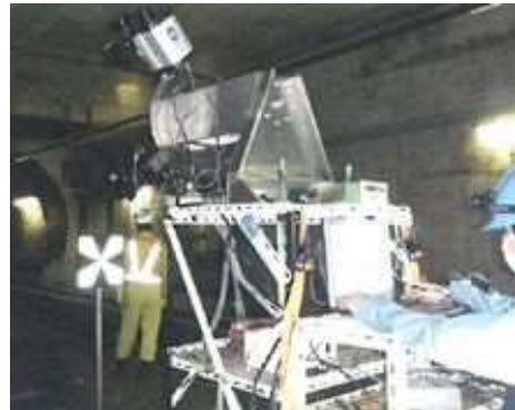
2. 画像診断によるコンクリートの損傷箇所調査
