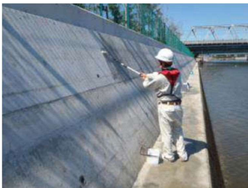
3. 表面含浸工法によるコンクリートの保護
