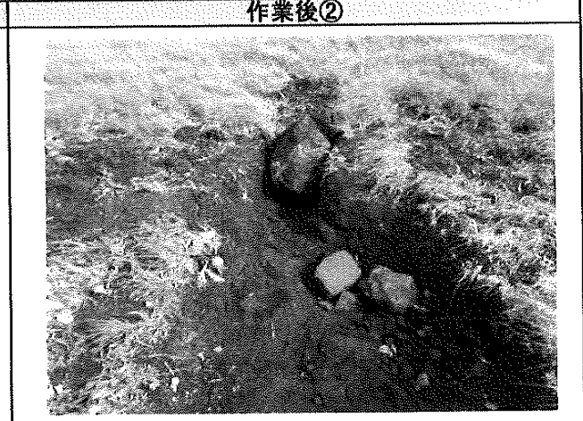
切削中に掘り出した岩を敷き詰め、浸透升替わりとした
