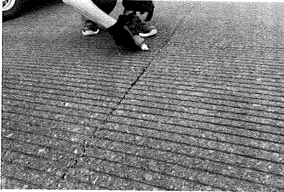
補修材をひび割れ部に注入する。
