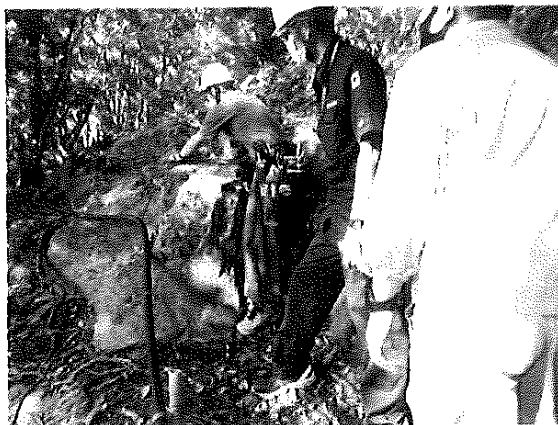
ケーブルが垂れ下がっていた箇所をバインド線で岩の方へ吊り上げることで、自重による負荷を軽減。
