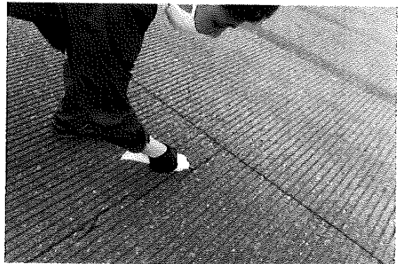
補修材をひび割れ部に注入する。
