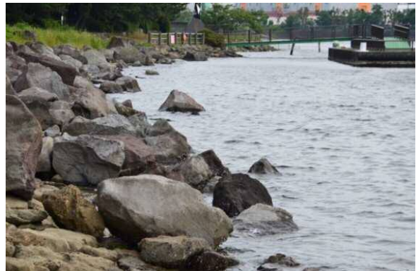
水辺に創出した近自然型の護岸 (大井ふ頭中央海浜公園)
