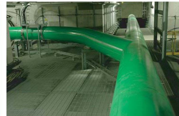
ごみ処理（管路収集システム）
