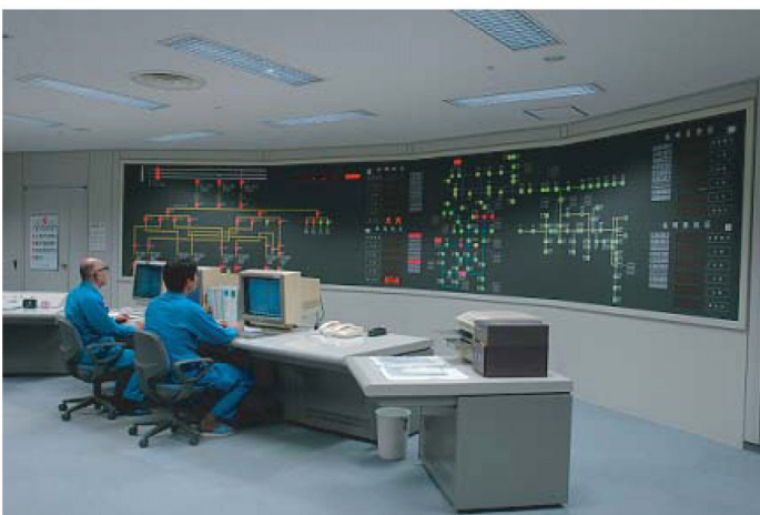
テレコムセンター内 共同溝管理センター
