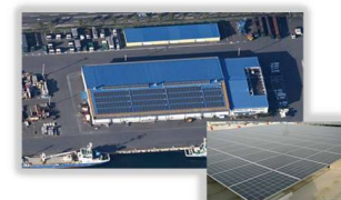
太陽光パネルの整備
