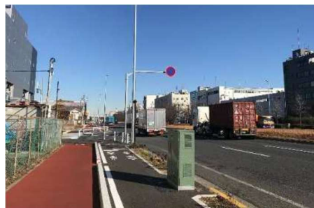
図 I-3-4 臨港道路の無電柱化
