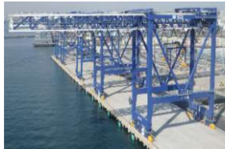
図 I-3-3 耐震強化岸壁・免震クレーン
