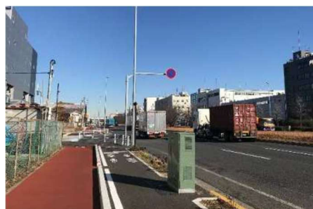
臨港道路の無電柱化
