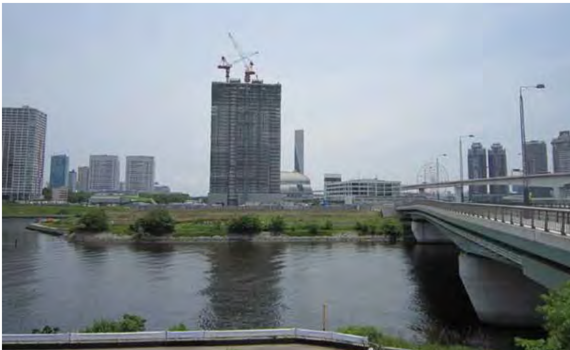
2 区域の補助 315 号線付近
