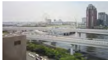
首都高速湾岸線付近
