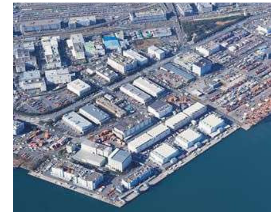
■ふ頭背後の倉庫群
