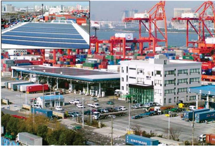
図表 54 ふ頭における太陽光発電導入例（大井 4 号バース ゲート屋上）
