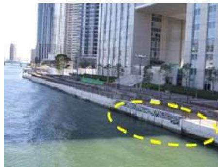
水生生物に配慮した護岸 (2)
