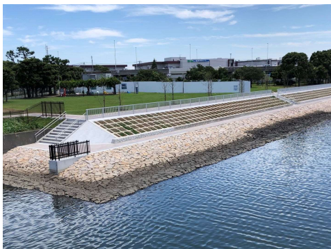
公園と連続された防潮堤（1）
