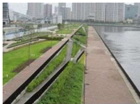
公園と連続された防潮堤（2）
