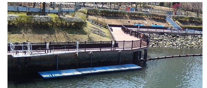
東品川海上公園仮設棧橋
