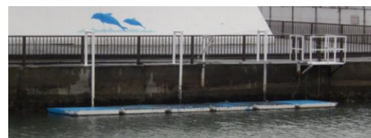
浮桟橋 (対岸より)
