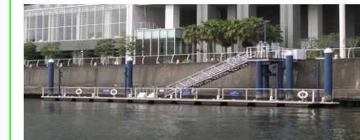
ワールドシティアタワーズ棧橋
