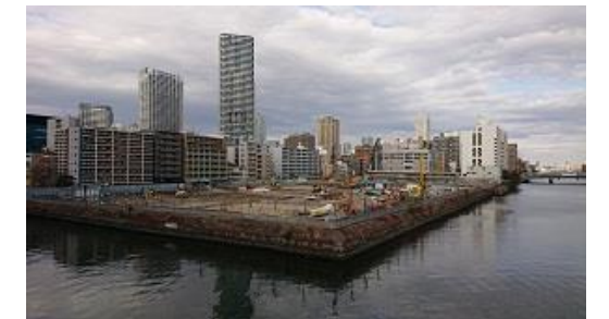
着工前の朝潮運河からの様子
