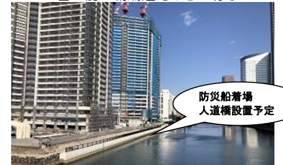
現在の朝潮運河からの様子
