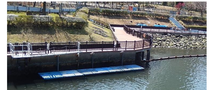
東品川海上公園仮設棧橋
