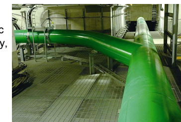
Conduit for Garbage Collection
