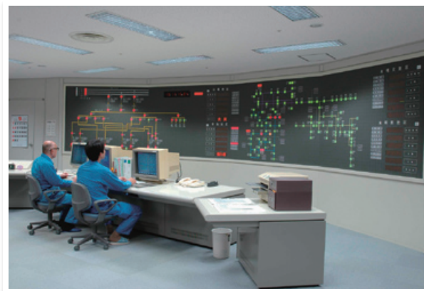
共同溝管理センター
