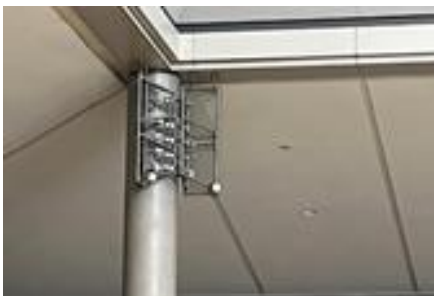
5G 敷設工事
