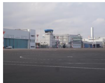
○ハンガーを閉鎖し、異常の有無を点検中
