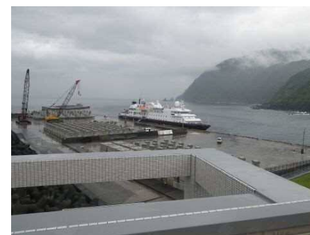
写真 岸壁接岸状況（八丈島神湊港）
