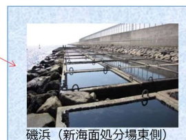
磯浜 (新海面処分場東側)
