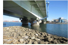
劣化調査状況 (城南大橋)
