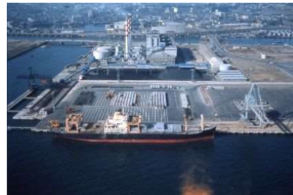
完成した品川コンテナふ頭（昭和 40 年代）
