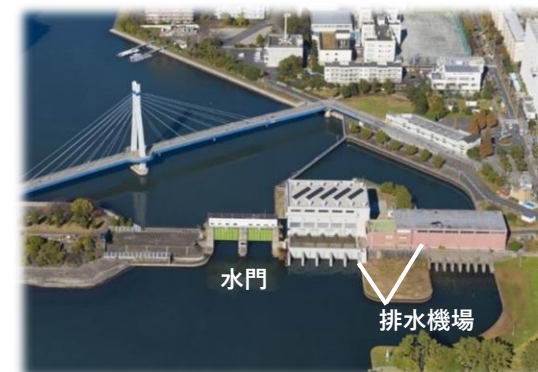
<辰己水門・排水機場>
