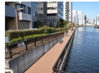
< 内部護岸上部の遊歩道 >
