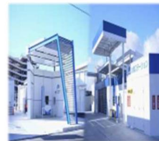
水素ステーション 分散型発電設備の整備
