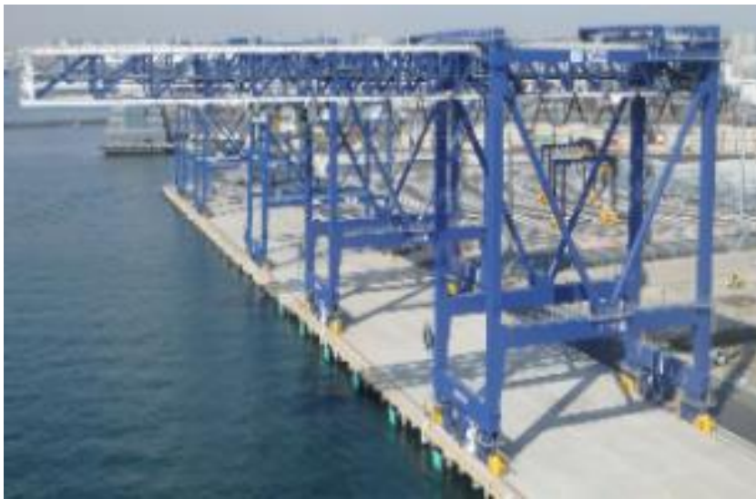
耐震強化岸壁・免震クレーン
