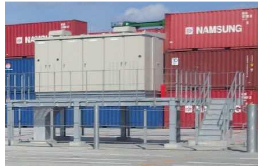
電源設備等の嵩上げ
