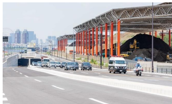
東京港海の森トンネル
